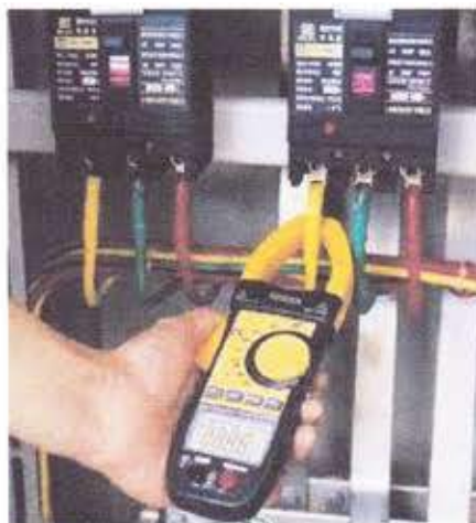
Gambar.E.8. Ilustrasi Pemeriksaan menggunakan Clamp Meter
