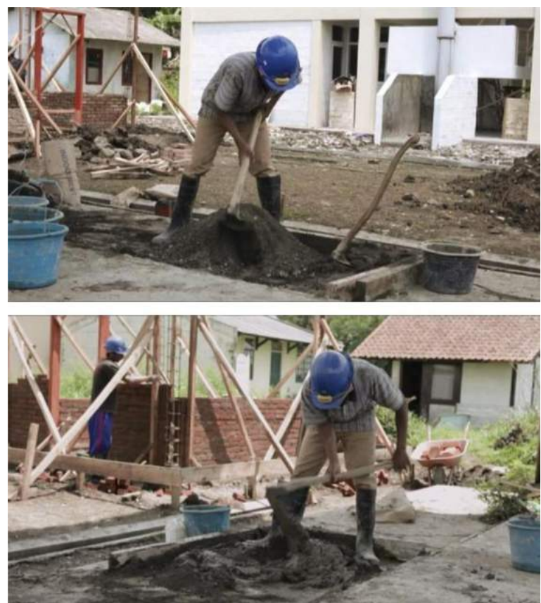
Gambar 8. Proses Pencampuran Mortar
