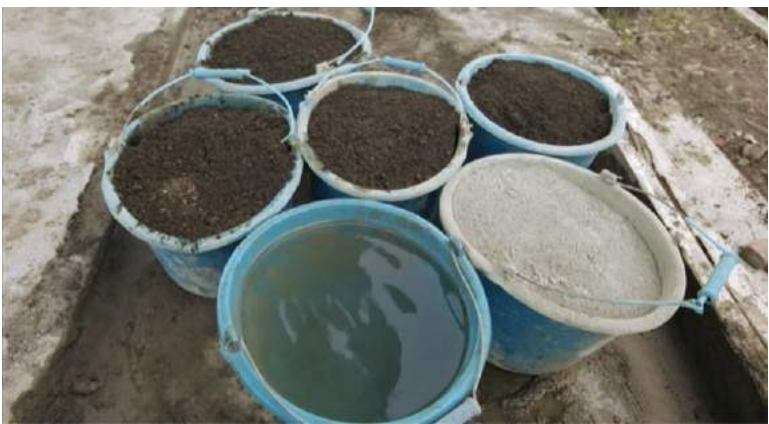
Gambar 7. Bahan Campuran Mortar
