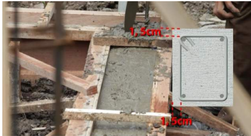
Gambar 19. Balok Pengikat/ Sloof
