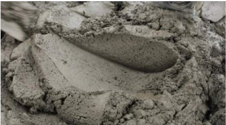
Gambar 9. Hasil Pencampuran Mortar Yang Baik
