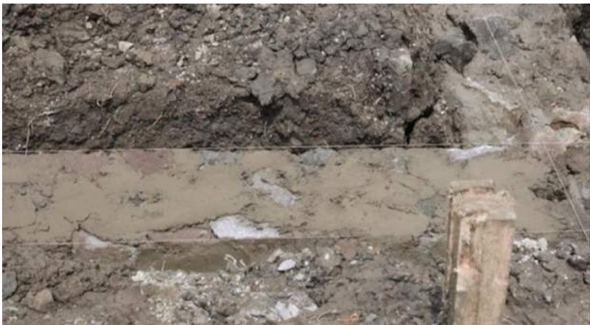
Gambar 11. Pondasi Dari Batu Kali/Gunung
