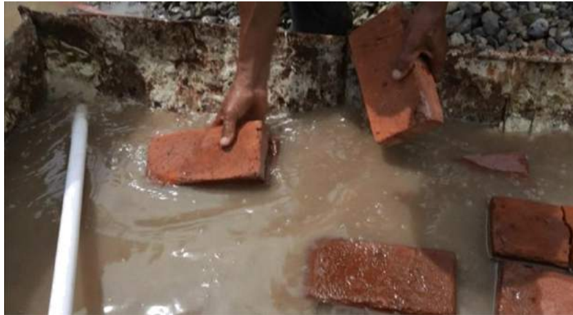
Gambar 15. Perendaman Batu Bata Sebelum Dipasang
