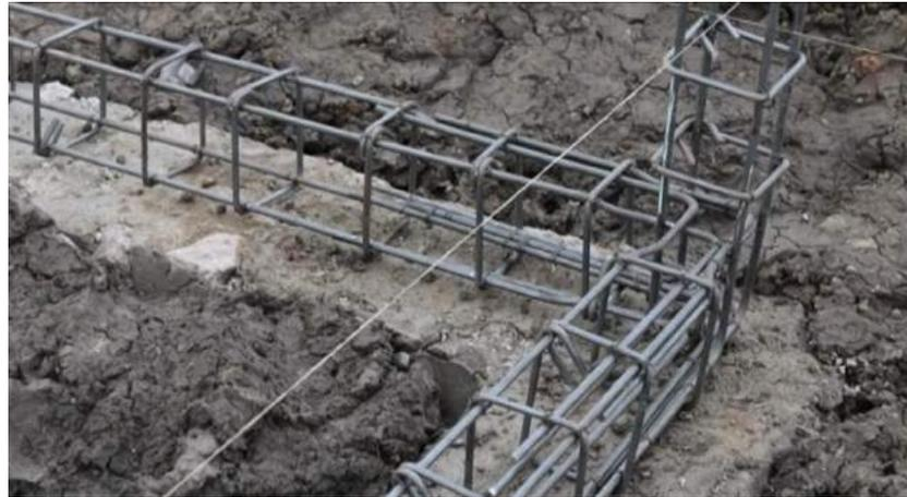
Gambar 44. Hubungan Antara Tulangan Balok Pengikat/ Sloof dengan Tulangan Kolom
