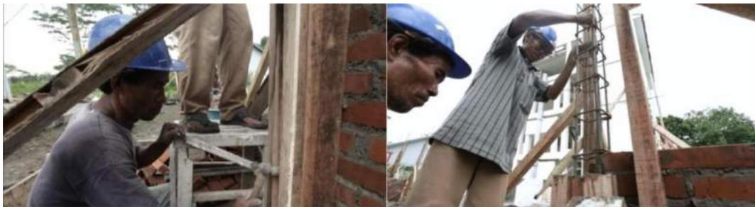
Gambar 57. Pemasangan Beton Dengan Memukul-mukul Cetakan/*Bekisting* dan Campuran Beton Dirojak Menggunakan Besi atau Bambu
