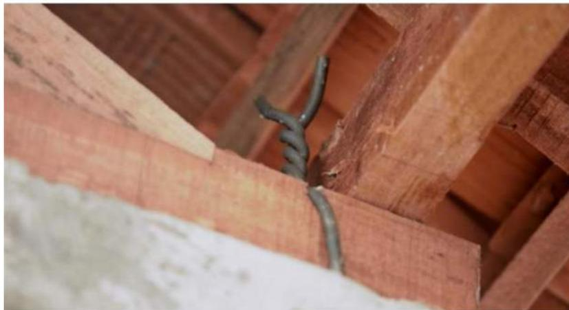
Gambar 51. Pengikatan Kuda-Kuda Kayu Pada Balok Keliling/ Ring Menggunakan Angkur
