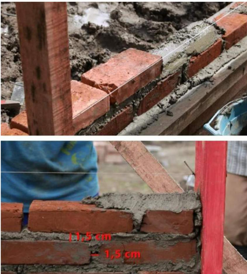
Gambar 41. Proses Pemasangan Batu Bata Untuk Dinding
