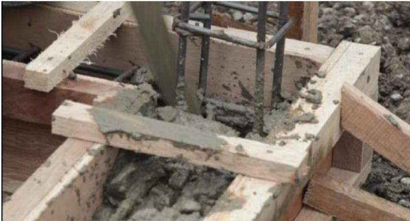
Gambar 58. Pengecoran Balok Pengikat/*Sloof*
